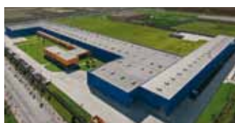
Hörmann Tianjin, Cina
